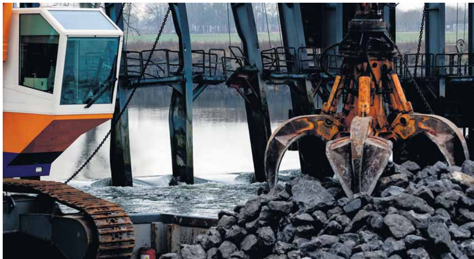
Rijkswaterstaat bouwt een tijdelijke dam bij de beschadigde stuw van Grave. Zo kan op de Maas tussen Grave en Sambeek weer gevaren worden. Foto:ANP/Robin van Lonkhuijsen
